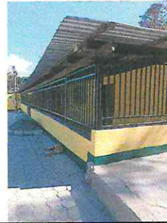
Foto 6: Instalación de piso cerámico (fachaleta)
