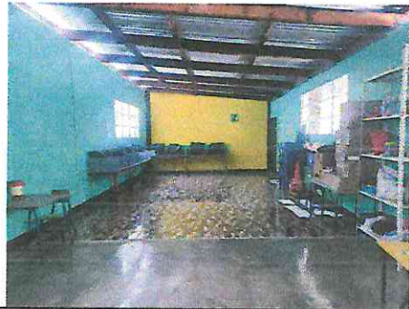
Foto 2: Construcción de pared para poder dividir el aula.
