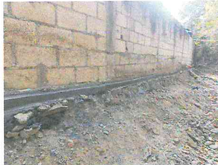
Foto 2: Recubrimiento y repello de muro perimetral
