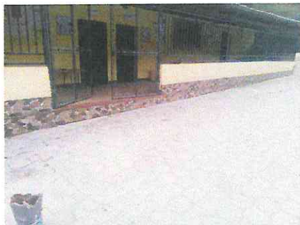
Foto 5: Pintura interior y exterior de la escuela
